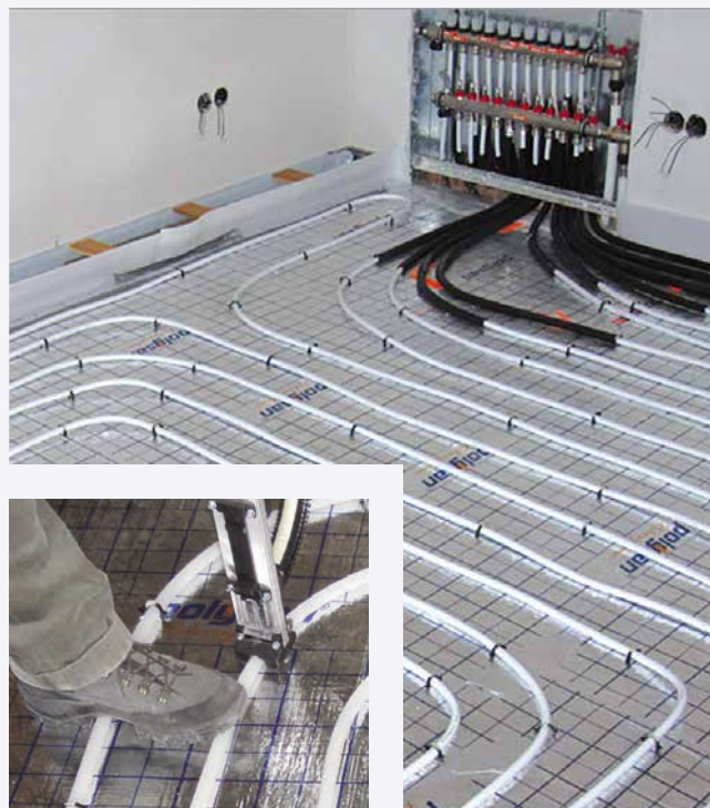
Fixieren der Rohre mit dem Tacker-Gerät
